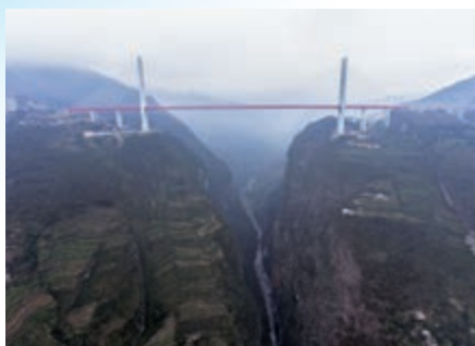
世界第一高桥——北盘江大桥
