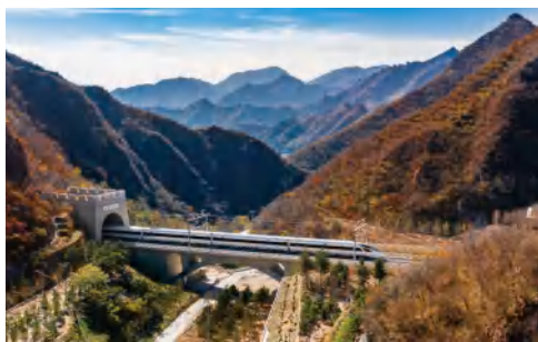
图 4.34 新八达岭隧道
