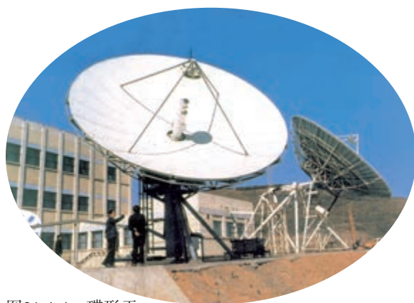
图21.4-4 碟形天线用来接收来自卫星的信号
