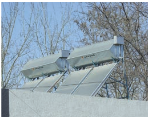
图22.3-5 楼顶上的太阳能集热器为住户提供热水
